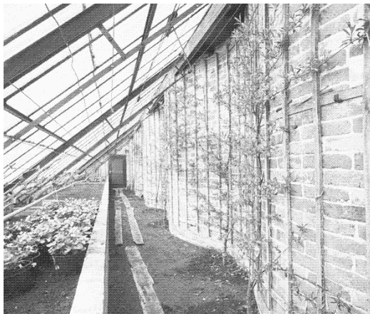
Serre construite contre un mur à fruits ondulé Source : Les murs à fruits : L'agriculture urbaine du 17e siècle, Low-tech Magazine, Décembre 2015
