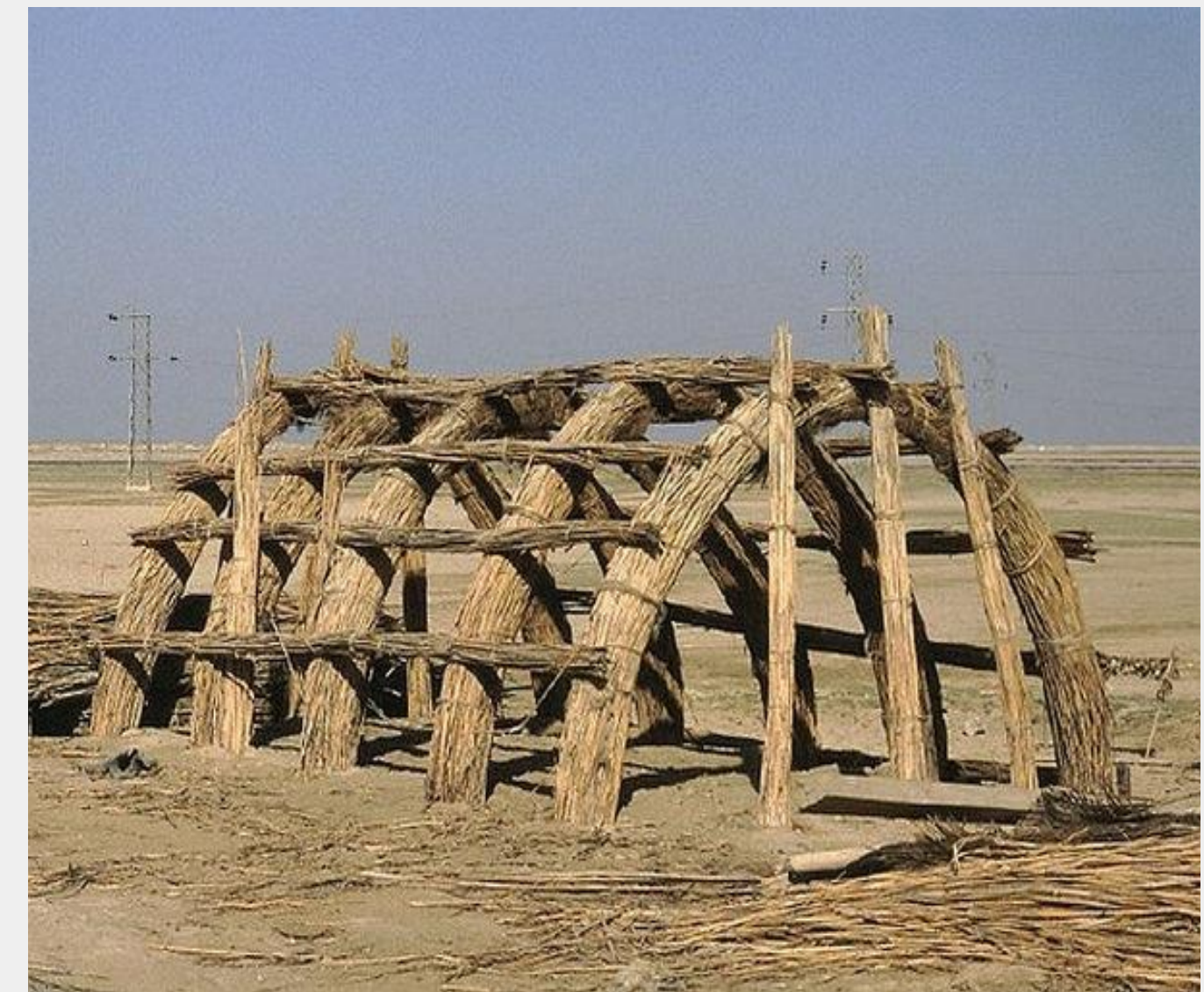
Structure faite en roseau
